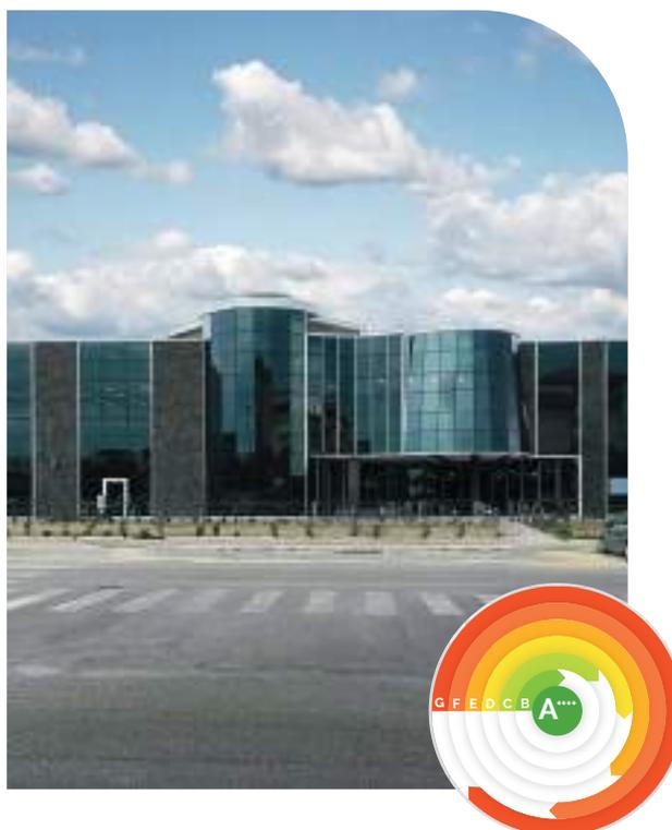
Vetrature composte da infissi in alluminio, pareti a muratura a "secco", pavimenti interni sopraelevati, impianto per il ricambio d'aria a tre vie e un sistema per la gestione degli impianti tecnologici sono solo alcuni degli accorgimenti, che garantiscono i più alti standard di efficienza dell'edificio. La maggior parte dei materiali di costruzione usati è certificata LEED, compresa la struttura portante.
